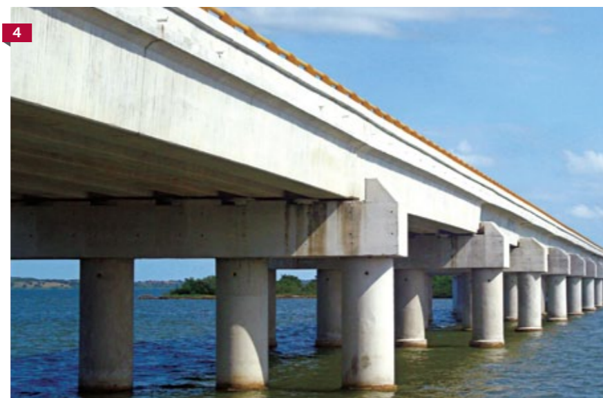
1. Cimentación tanque de Melasa, Ebano, San Luis Potosí. Concreto T.E. a 5 hrs. 2. Muelles para el arribo de mercancía, Tampico, Tamaulipas. Concreto T.E. a 4 hrs. 3. Vivienda, La Paz, Baja California. Concreto T.E. a 12 hrs. 4. Trabes, Horconitos Veracruz. Concreto T.E. a 5 hrs.
