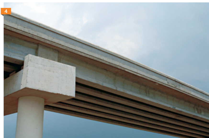
1. Elementos prefabricados 2. Flujo de revenimiento 3. Autocompactabilidad 4. Edificación construida con elementos prefabricados
