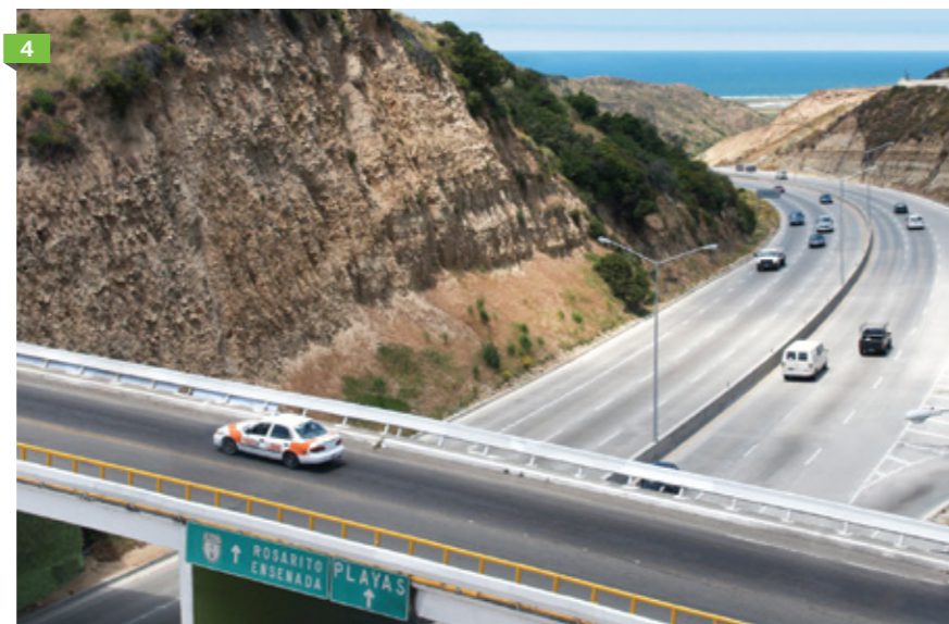
1. Colinas del Sol 2. Aplicación de Relleno Fluido 3. Construcción sub-base para pavimentos 4. Base pavimentación Tijuana, B.C.
