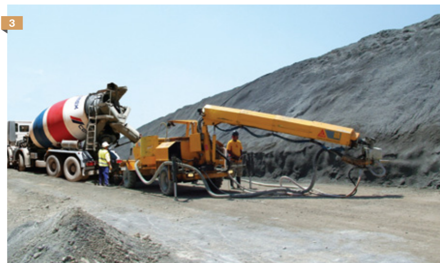
1. Aplicación para revestimiento de cualquier tipo de túneles 2. Aplicación de Concreto Profesional MR Lanzado Arquitectónico (con color) 3. Aplicación en exterior
