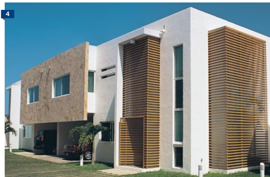
1. Capilla del Seminario Menor, Mérida, Yucatán 2 y 3. Colocación de mezcla 4. Casas Montes de Ane
