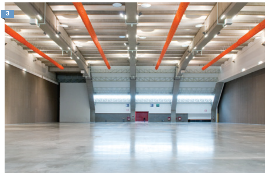
1. Aplicación para pisos industriales 2. Colocación con regla láser 3. Colocación en sistema postensado
