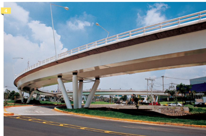
1. Torres Myth, Guadalajara, Jalisco 2. Vivienda de interés social 3. Productividad en construcción de vivienda monolítica 4. Nodo vial Av. Patria y Av. Acueducto, Jalisco
