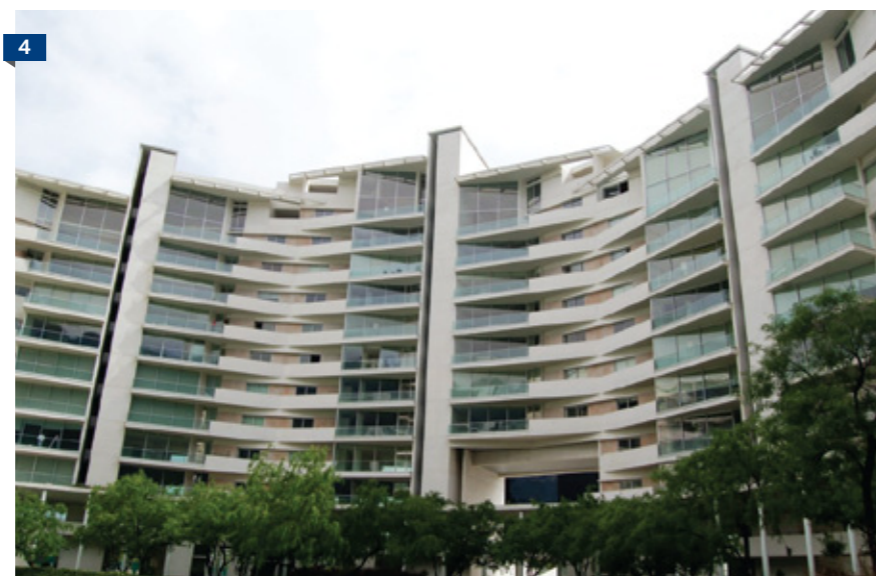
1. Domo monolítico 2. Interior de domo monolítico de concreto 3. Vigas de concreto pretensado 4. Residencial Punto Central, San Pedro Garza García, N.L.
