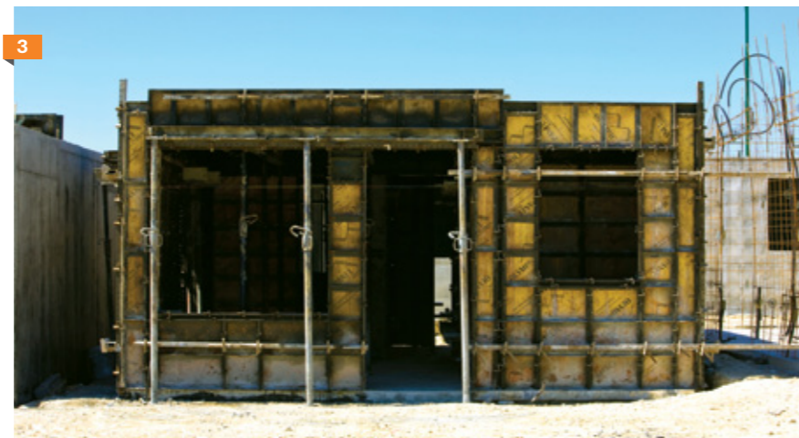
1. Apariencia final 2. Descimbrado temprano (6 a 12 horas) 3. Armado de molde y colado monolítico
